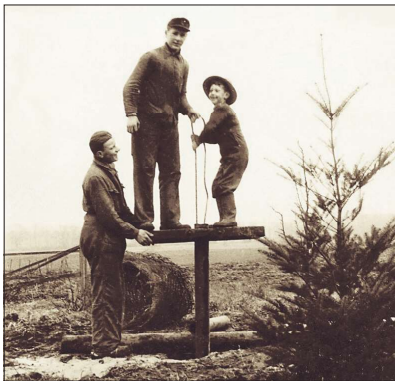
Spülen eines Filters in Emlichheim.
